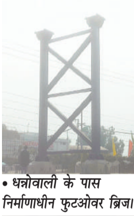
• धनोवाली के पास निर्माणाधीन फुटओवर ब्रिज।
